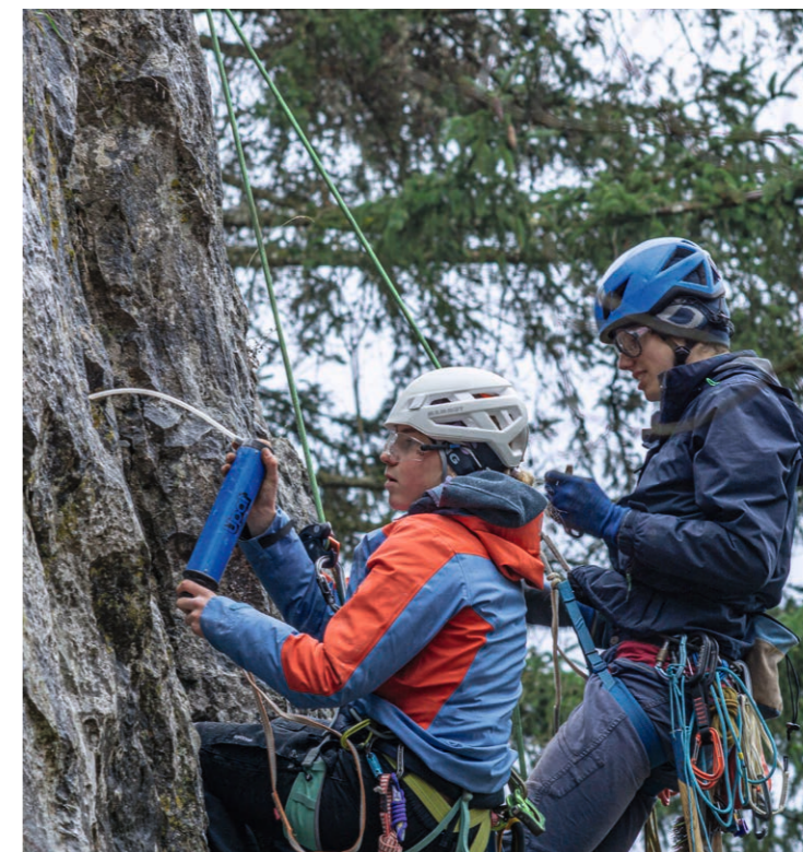
↑ Mit dem Ausbläser wird das Bohrloch gereinigt damit der Kleber später gut hält ↓ Team Spitzer Stein nach getaner Arbeit
